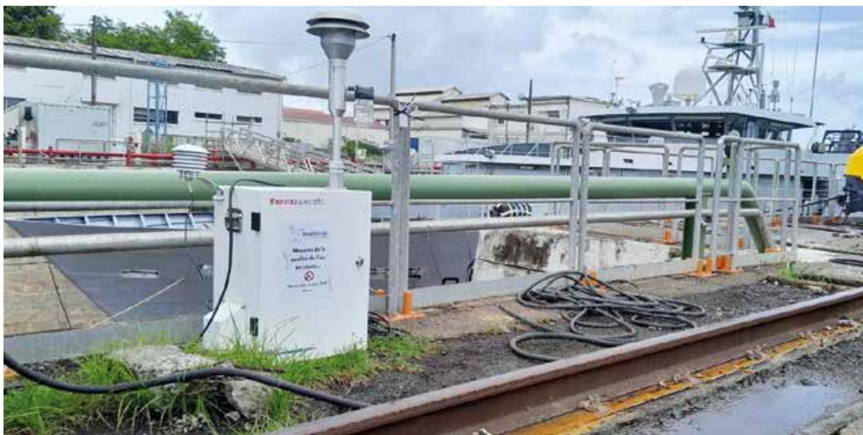
Capteur de la qualité de l'air installé au bassin de radoub.
