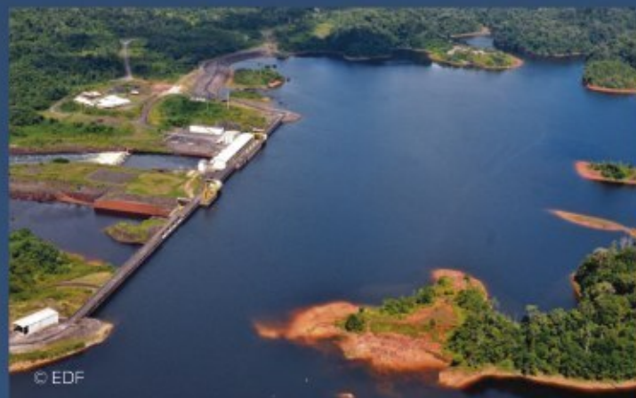
Barrage de Petit Saut
