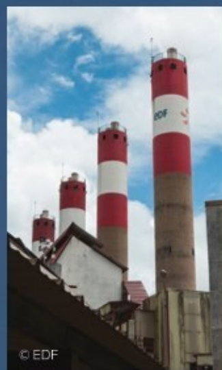
Centrale de Dégrad des Cannes
