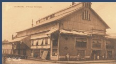
Usine électrique avant 1975
